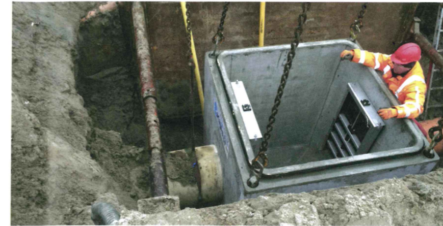
Figuur 2. Plaatsing van de nieuwe gemaalkelder voor het VGS 2.0-gemaal door Mous Waterbeheer
